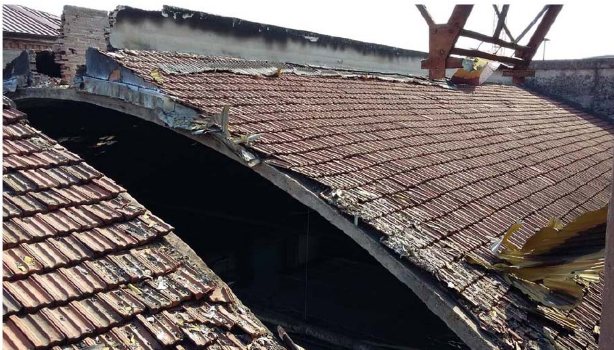
F3 Breccia nel tetto che sarà coperta con serramento trasparente per consentire una migliore illuminazione del reparto.
