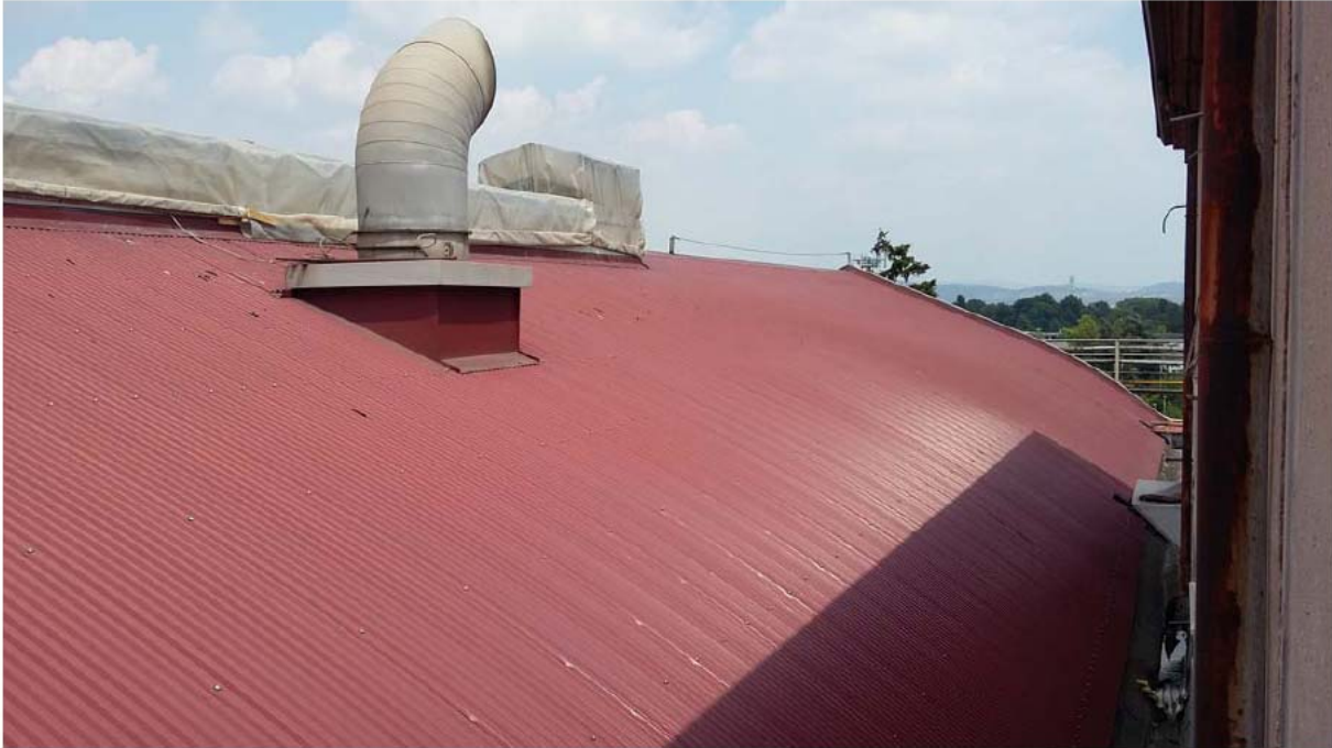
F4 Vista della linea vita sulla copertura verso il canale Camuzzoni.
