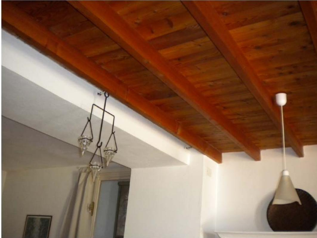
Foto 16 Appartamento con solaio in laterocemento, rifinitura con travi a vista
