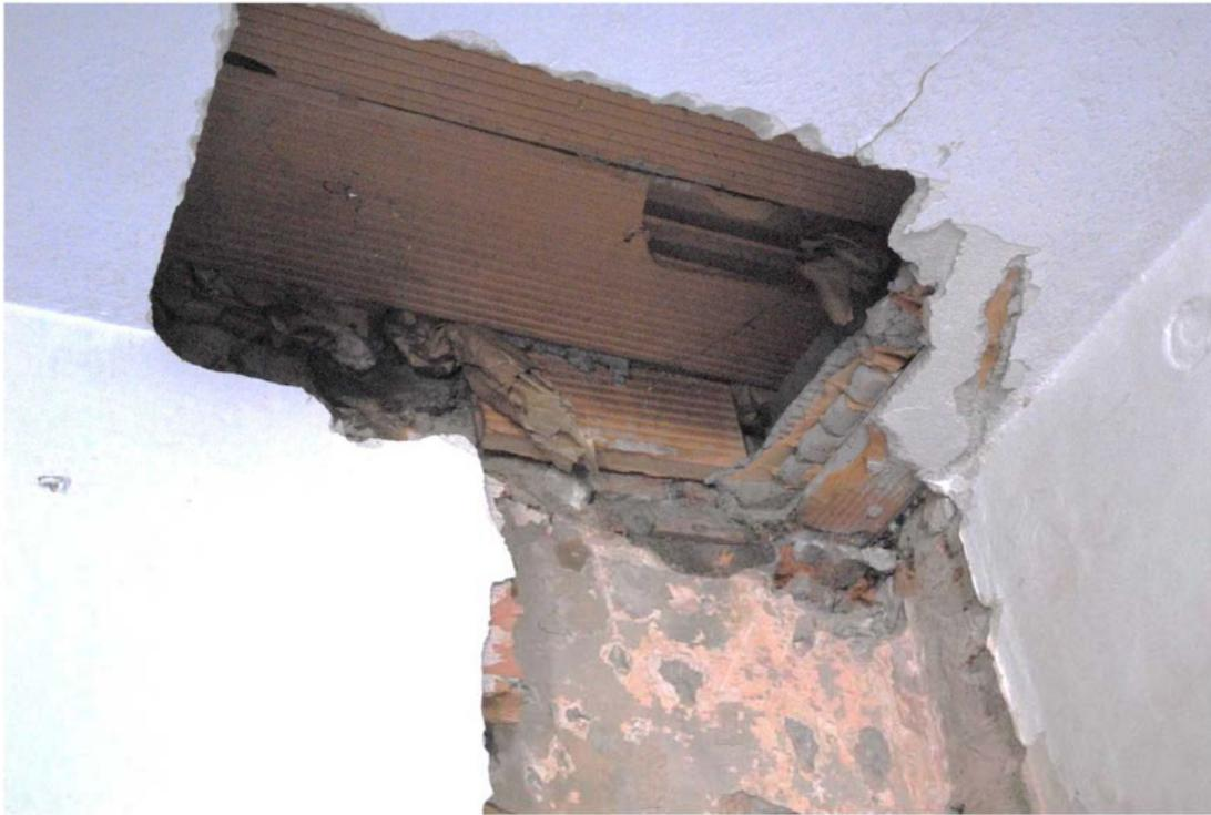
**Dettaglio dei solai con struttura di tipo Varese**
