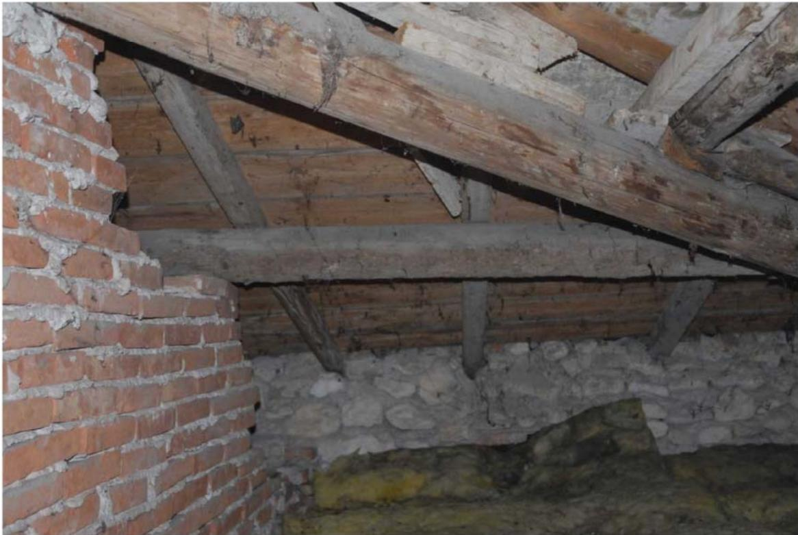
**L'orditura lignea delle coperture dell'edificio che risulta in continuità con quella della tettoia esterna**
