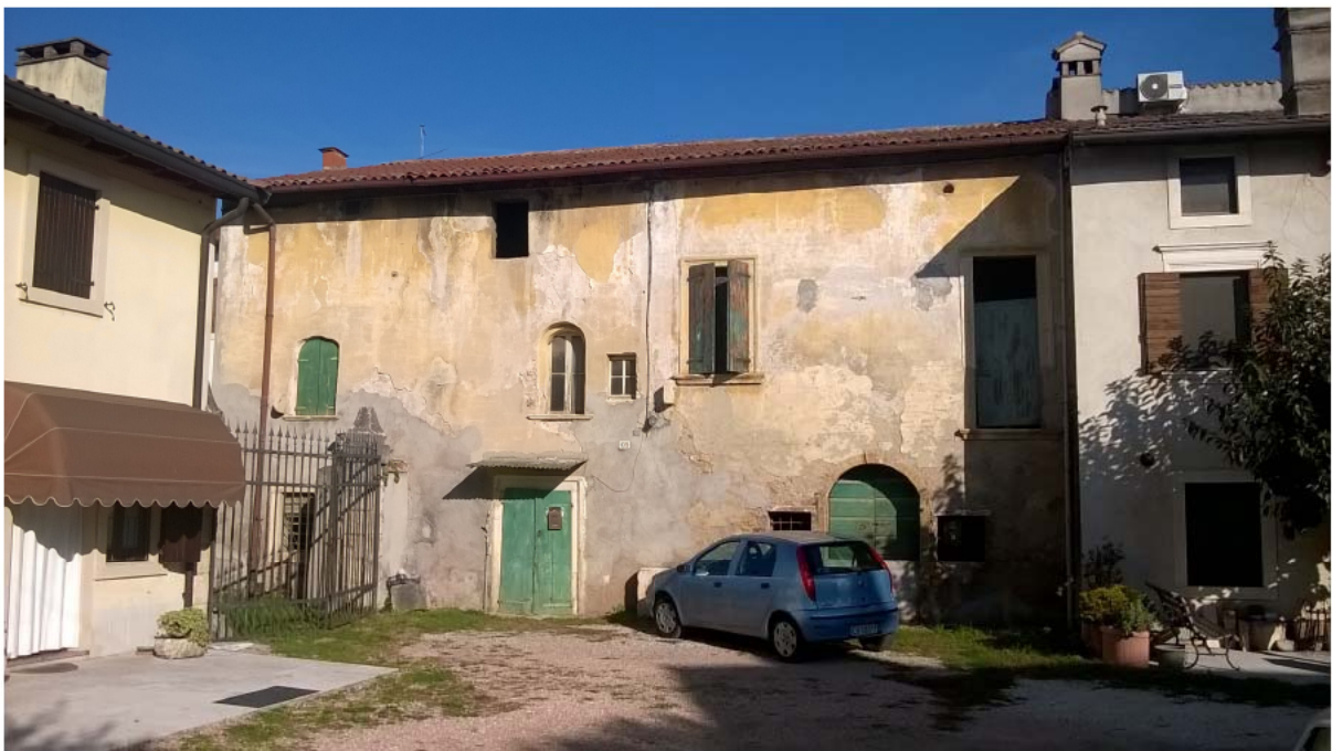
Vista del fabbricato d'angolo dalla prima corte
