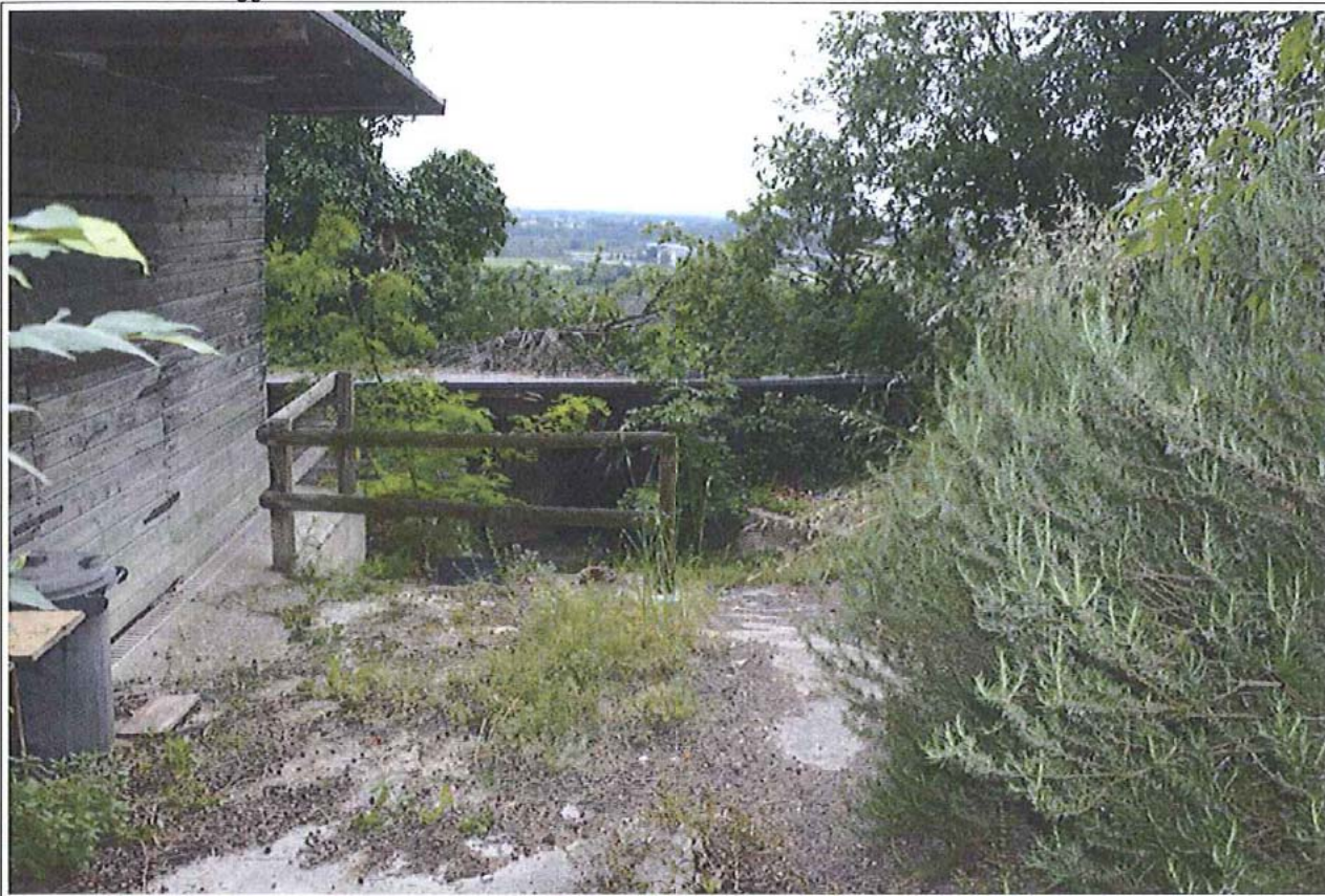
Foto Nr. 2_manufatto B
