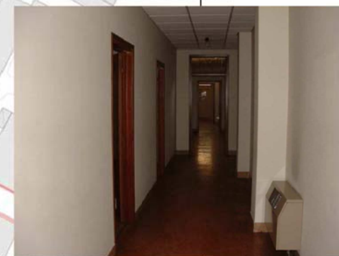
Foto 12_ Interno degli uffici sopra l'officina
