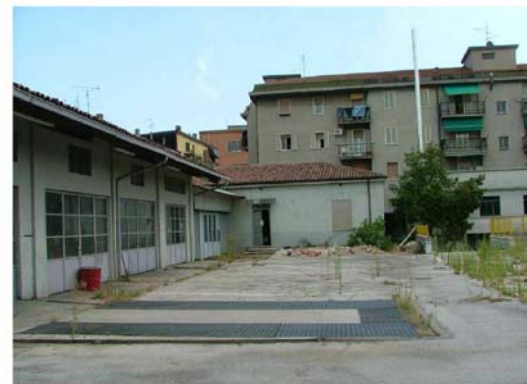
Foto 5_ Dal cortile interno verso edifici confinanti ad est
