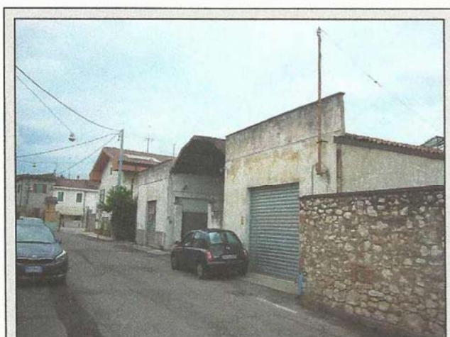
FOTO n.1 Vista dell'edificio da via Spalato, da sud verso nord.
