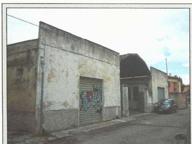
FOTO n.1 Vista della facciata principale dell'edificio da via Spalato, angolo nord-ovest.
