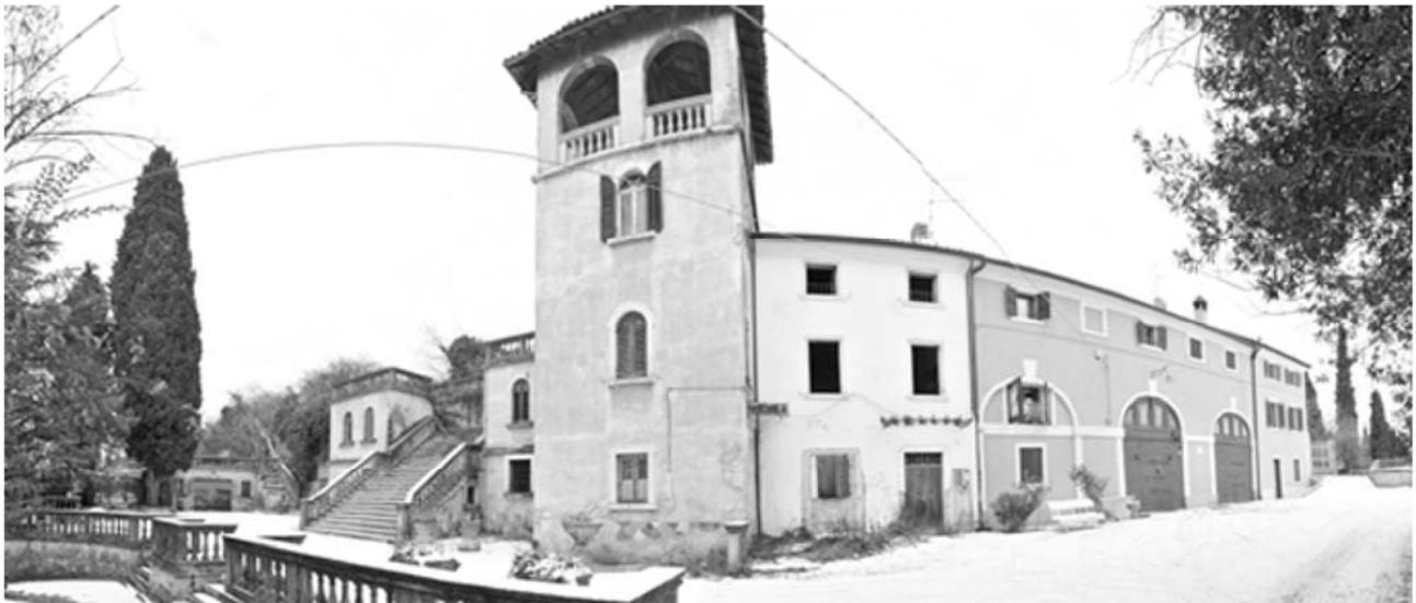
fig. 3 vista d'insieme del prospetto sud della corte rurale che ha subito un importante intervento nel dopoguerra con la costruzione di una torretta, una imponente scalinata e due corpi laterali con tetto piano.
